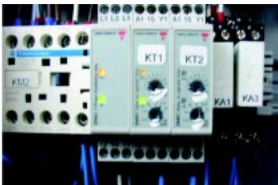
**NOTE.** Lors de l'arrêt de la machine en sécurité, le compresseur s'arrête immédiatement et le moteur du tambour qui tourne pendant 18 minutes (Le retard à l'arrêt est contrôlé par le relais KT2 – Les deux LED Vert et Jaune allumées fixe)
